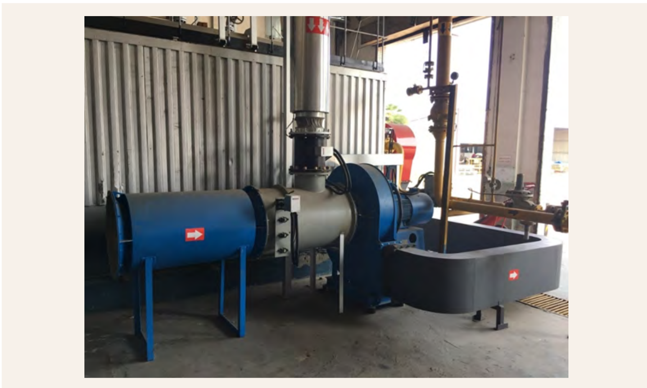
Obrázok 35: Plynový horák pre ultranízke oxidy dusíka (29)
